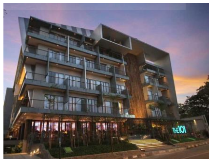
Gambar 2.43 Shaft Plambing pada Fasad (Sumber :
