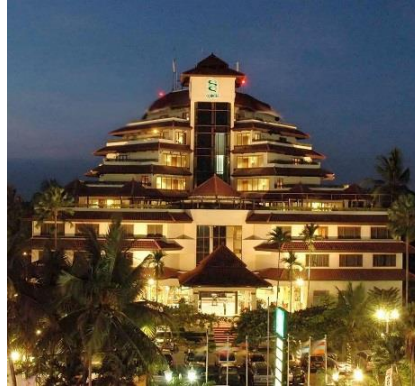
Gambar 2.42 Shaft Lift pada Fasad (Sumber :
