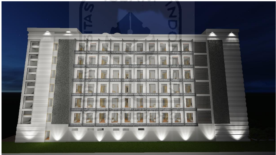
Gambar 4.34 Pencahayaan Buatan Fasad sisi Utara
