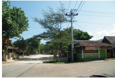
Gambar 3.6 Pasokan listrik dari PLN (Sumber : Dokumentasi Pribadi, 2014)
