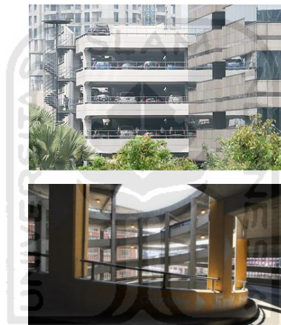
Gambar 15 : gedung parkir konvensional (sumber : google images )
