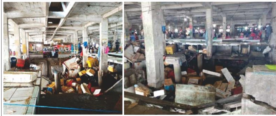
Gambar 2-21 Tampak Dalam Bangunan Pasar (Sumber : Dokumentasi Penulis, 2016)
