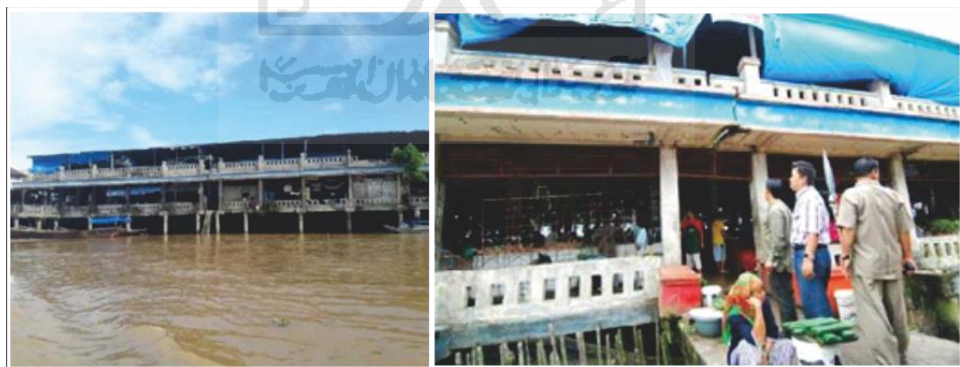
Gambar 2-20 Tampak Luar Bangunan Pasar
