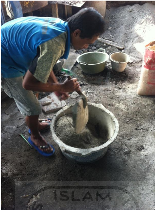
Mencampur agregat sebelum ditambahkan dengan air
