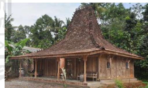
Gambar 81. Bangunan Rumah Adat Limasan Sumber : https://rumahjoglo.net/
