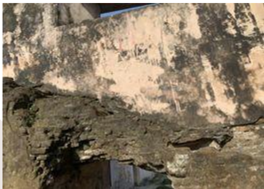
Tangga menuju lantai 2 melalui bangunan di sisi pojok barat
