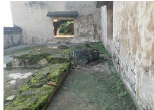
Area Bangunan di sisi barat sisa reruntuhan
