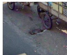
Resapan Air Hujan
