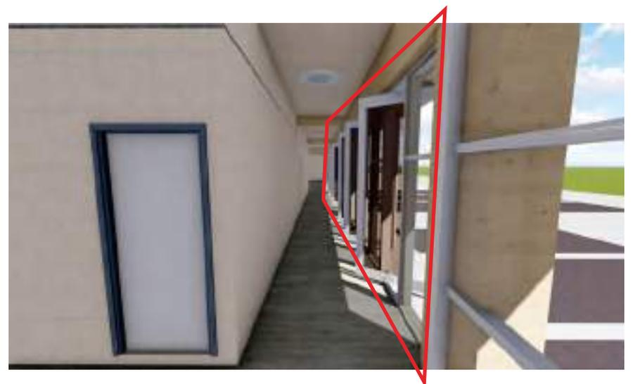
Gambar 143. Curtain Wall Kombinasi Jendela Pivot pada Koridor Backstage
