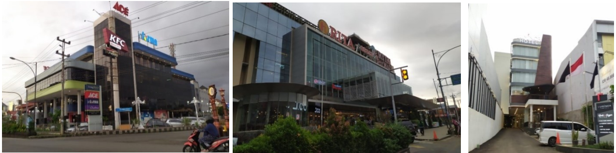
Gambar 1.7 Penampakan beberapa gedung di Jl. Jenderal Sudirman
