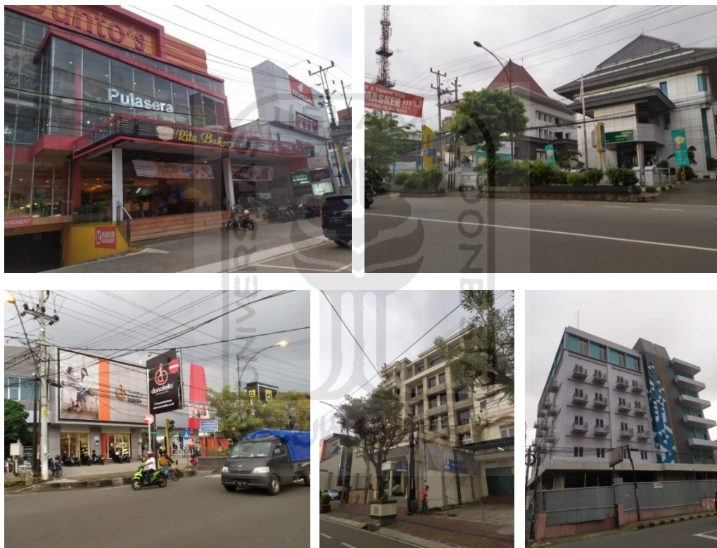
Gambar 1.8 Penampakan beberapa gedung di Jl. Jenderal Sudirman
