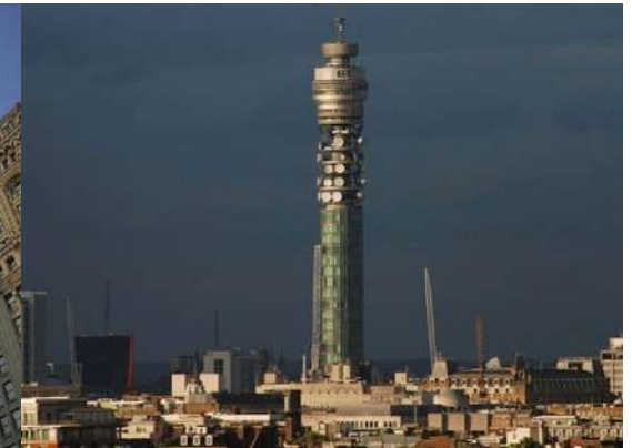
Gambar 3.4 : The BT Tower Sumber : wikipedia commons
