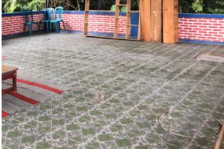
Gambar 10. Unit Pengolahan IPAL Komunal Ngudi Mulyo
