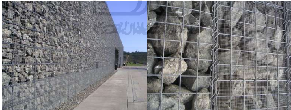
Gambar 2.20 Susunan Gabion
