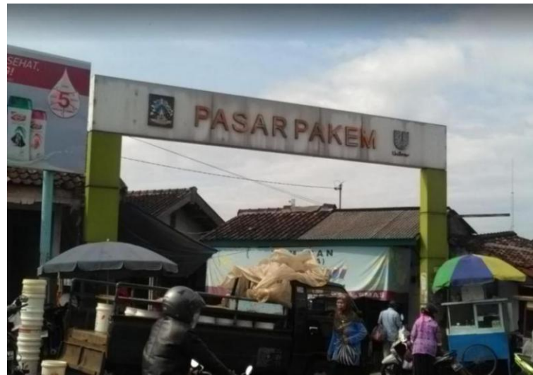
Gambar 1.3 Kondisi Eksisting Pasar Pakem
