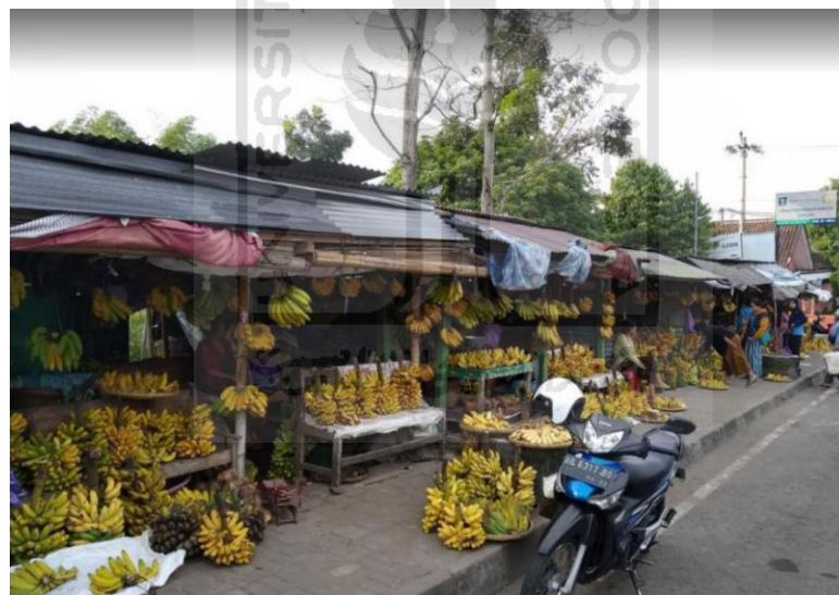
Gambar 1.4 Kondisi Eksisting Pasar Pakem
