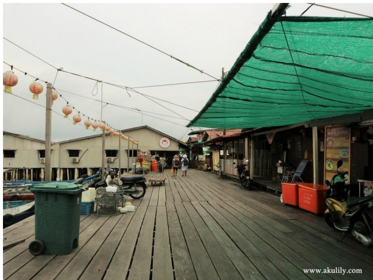
Gambar 2. 3 Landasan Kayu pada Chew Jetty (Sumber: http://akulily.com , tanggal akses: 28 Maret 2020)
