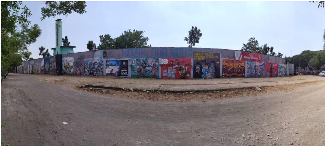
Gambar 9 Kondisi tembok sisi timur Pusat Olahraga Kridosono Kotabaru Yogyakarta Sumber: Penulis, 2019.
