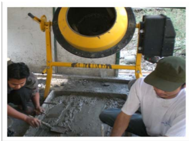
Gambar Pembuatan Campuran Dan Penuangan Ke Cetakan
