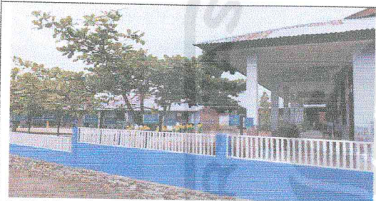
MIM Tamiang, dilihat dari samping belakang (memanjang)
