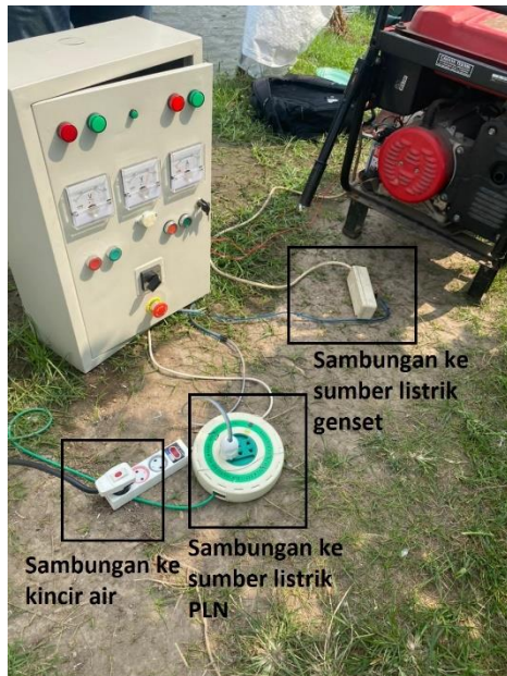
Gambar 5.17 Pemasangan alat pada plant
