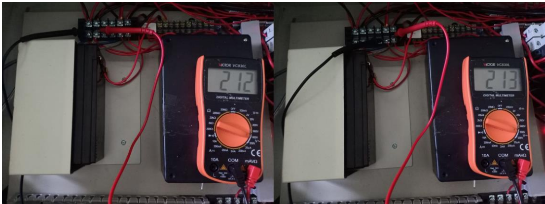
Gambar 5.13 Pembacaan nilai tegangan PLN (kiri) dan genset (kanan)
