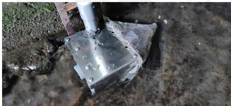
Gambar 5.5 Perbaikan Sensor water flow
