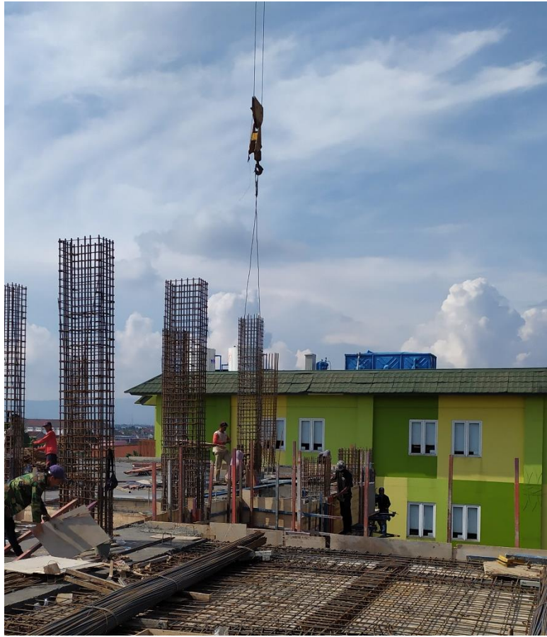
Gambar L3-5 Pemasangan Tulangan Kolom
