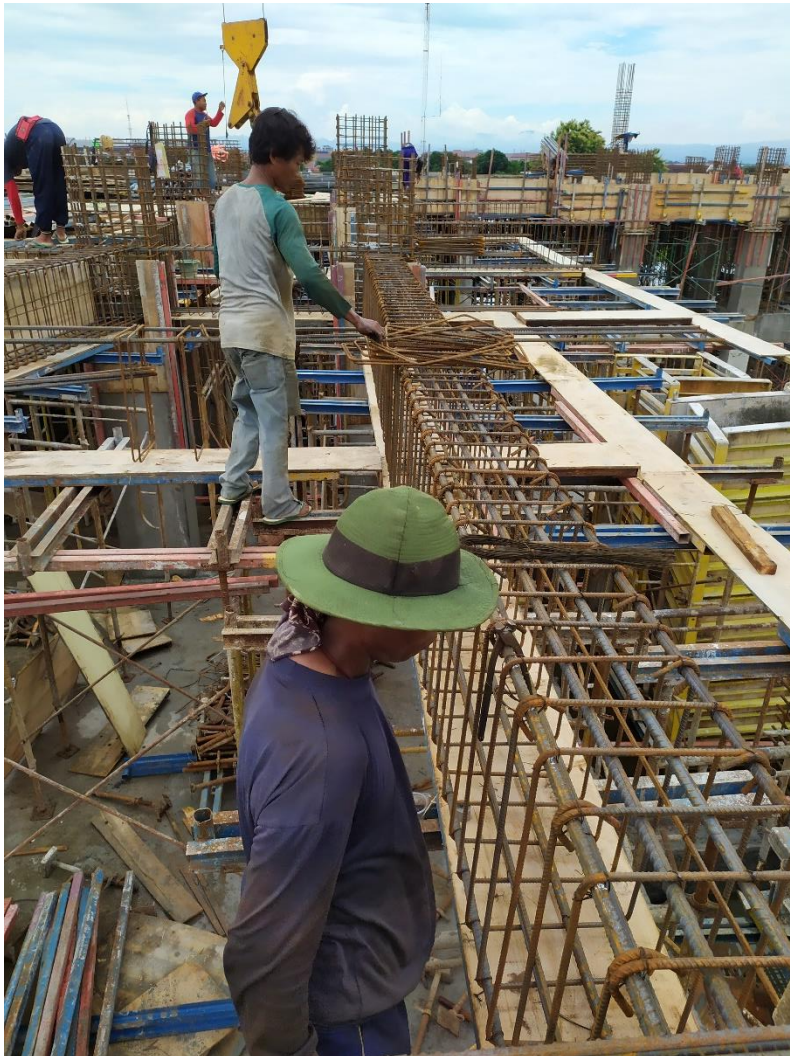
Gambar L3-6 Pemasangan Tulangan Balok
