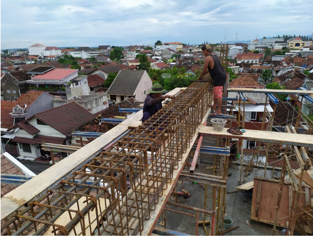
Gambar L3-7 Pemasangan Tulangan Balok
