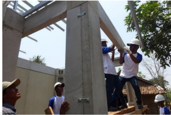
Gambar 1.2 Pemasangan Komponen Pracetak pada Rumah dengan Teknologi RISHA
