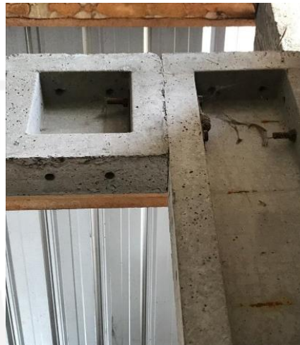
Gambar 5.4 Lekukan-lekukan pada pertemuan panel-panel pracetak
