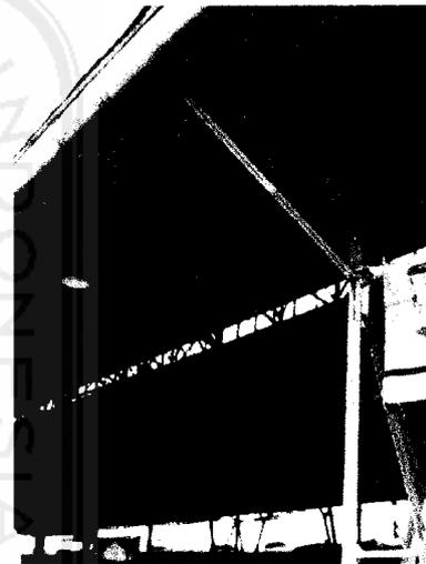
Bangunan utama juga ditutupi pada bagian atasnya dengan penutup atap sistem rangka baja melengkung. Bangunan lainya yang merupakan bangunan tambahan banyak menggunakan sisitem struktur rangka baja ( bengkel, depo ), dan sebagian menggunakan struktur rangka beton biasa.
