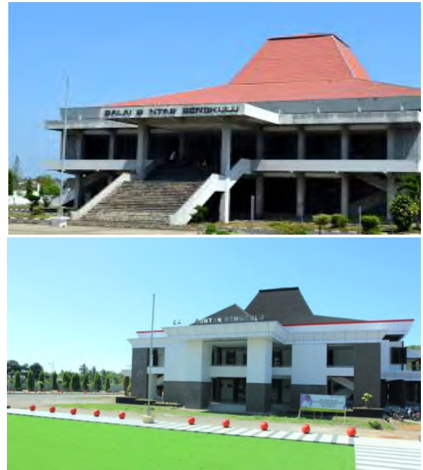
Gambar 1.6 Penampilan Bangunan Balai Buntar Sebelum dan Sesudah Renovasi Sumber : https://caribengkulu.com dan https://www.ewarta.co/
