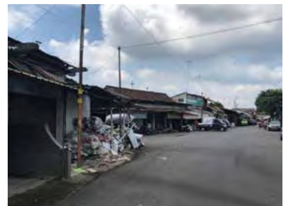
Kondisi Tampak Samping Bangunan B Sumber: Ilustrasi Penulis, 2020
