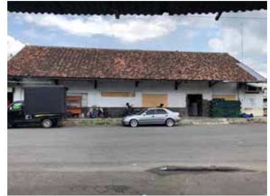
Tampak Samping Bangunan A Sumber: Penulis, 2020
