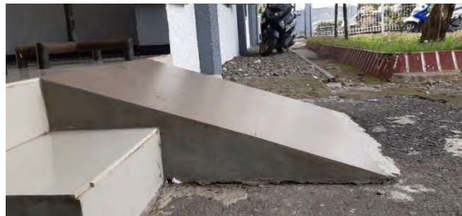
Gambar 1.8 Ram yang Cukup Curam dan Bertekstur Licin sehingga Membahayakan Pengguna
