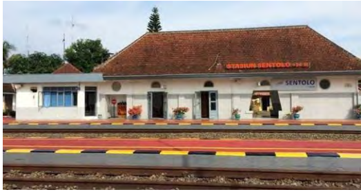
Gambar 1.4 Bangunan Stasiun Sentolo
