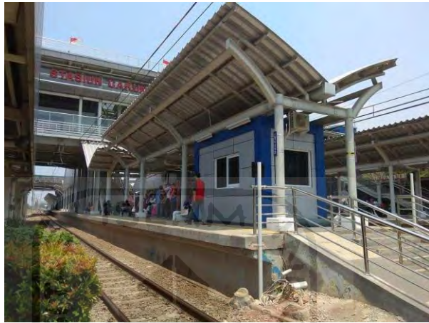
Gambar 2.12 Ruang PPKA Stasiun Cakung
