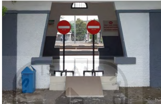
Gambar 1.9 Ram yang Cukup Curam dan Bertekstur Licin sehingga Membahayakan Pengguna
