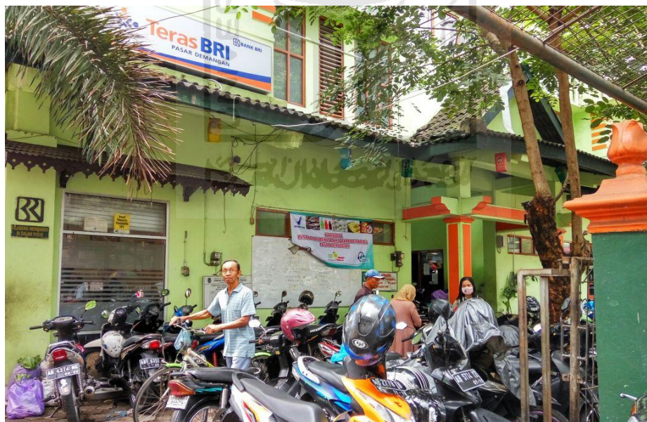
(Gambar 2.2.5.2 Foto fasad depan pasar demangan)
