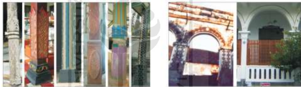
Gambar 4.2.1.2 d Kolom kayu dan bata serta dinding lengkung rumah Kalang
