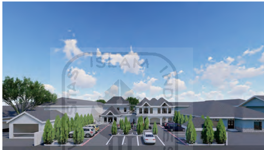
Gambar 6.1 Tampak Depan Bangunan
