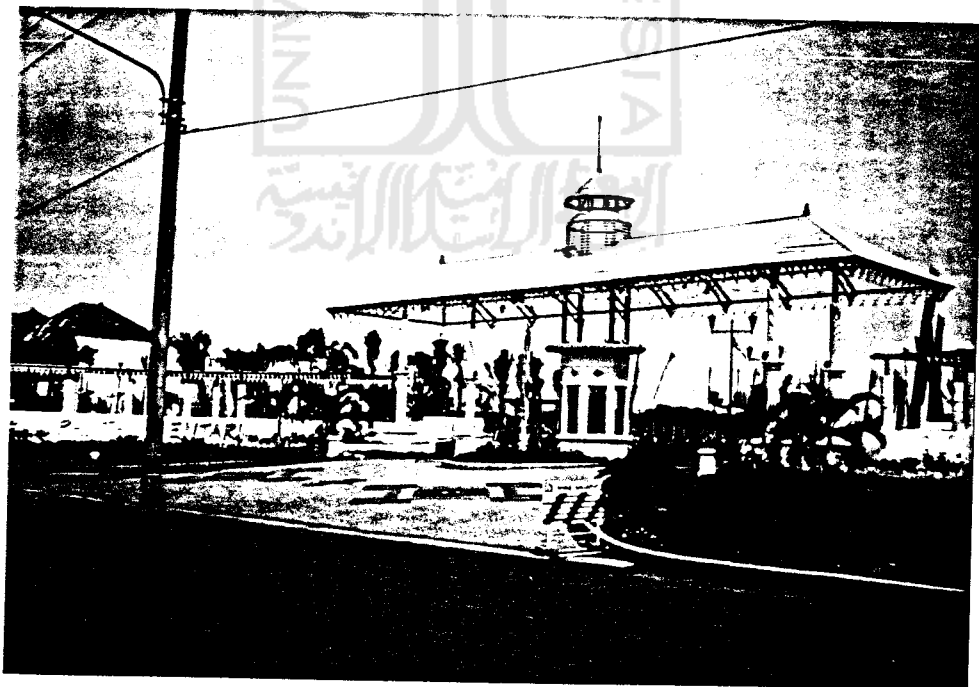
Gambar foto pintu gerbang Hotel Pantai Mentari yang sedang dibangun pada kawasan Pantai Kenjeran Surabaya.
