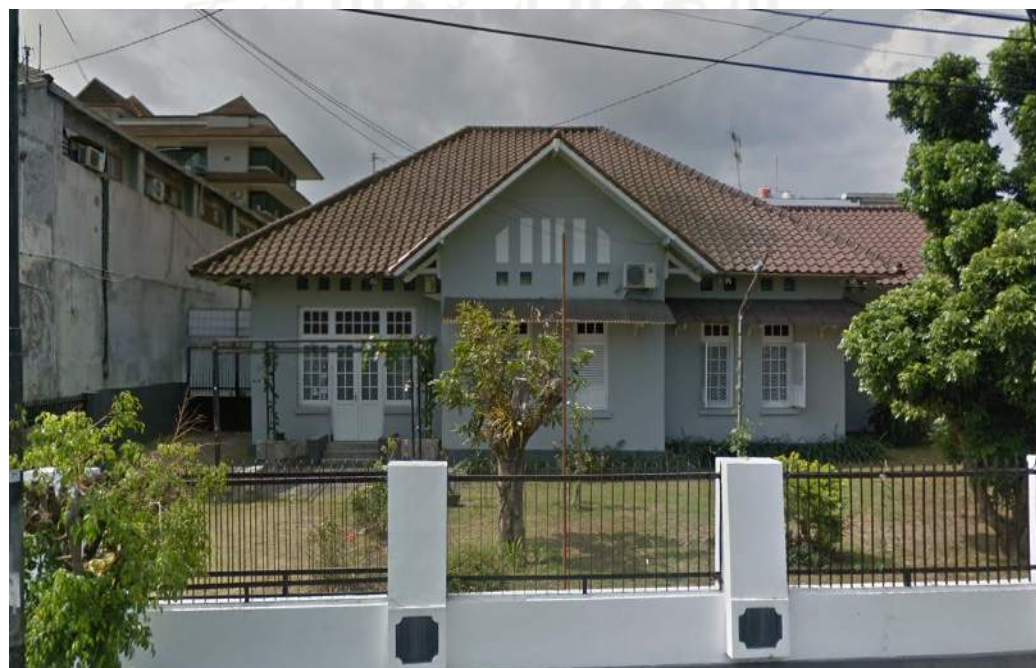
Gambar 2.10 Rumah di Area Kawasan Kotabaru Yogyakarta Sumber: Google Street View (2020)
