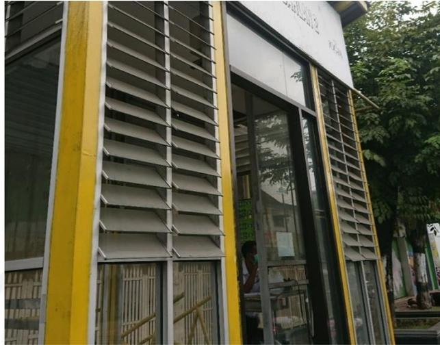
**Gambar 5. 16 Ventilasi Udara di Halte KHA Dahlan 2**
