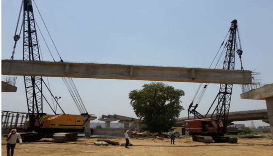
Gambar 3.5 Pemasangan Girder (Sumber: indiamart.com)
