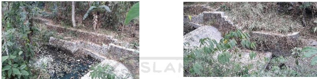
Gambar 5.11 Kondisi fisik morfologi sungai bangunan Sungai Kuning di 25,3 km zona 1 (hulu)
