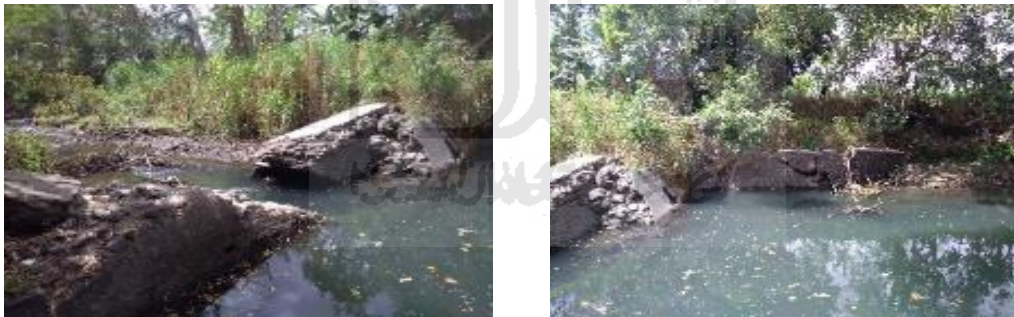
Gambar 5.7 Kondisi fisik morfologi bangunan Sungai Winongo di 8,12 – 10,00 km zona 3 (hilir)
