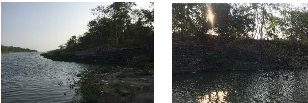
Gambar 5.8 Kondisi fisik morfologi sungai bangunan Sungai Opak di 4,60 – 5,10 km zona 3 (hilir)
