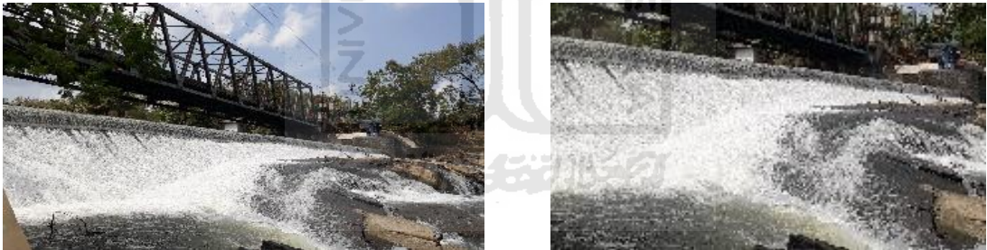
Gambar 5.10 Kondisi fisik morfologi sungai bangunan Sungai Opak di 21,92 – 21,95 km zona 2 (tengah)
