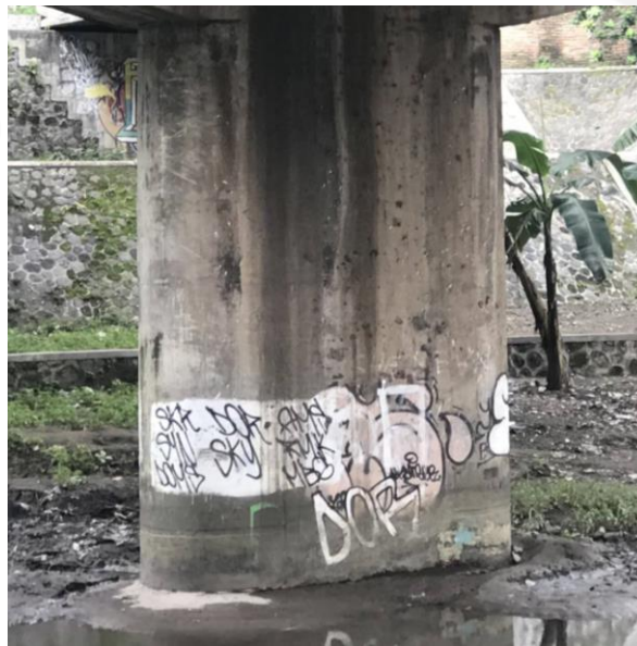
Gambar 5.24 Kondisi Pilar 2 Jembatan Bogem B
