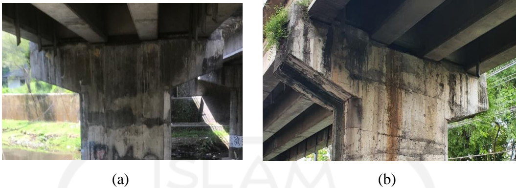
Gambar 5.42 Kepala Tiang (a) Pilar 1 (b) Pilar 2 Jembatan Bogem C
