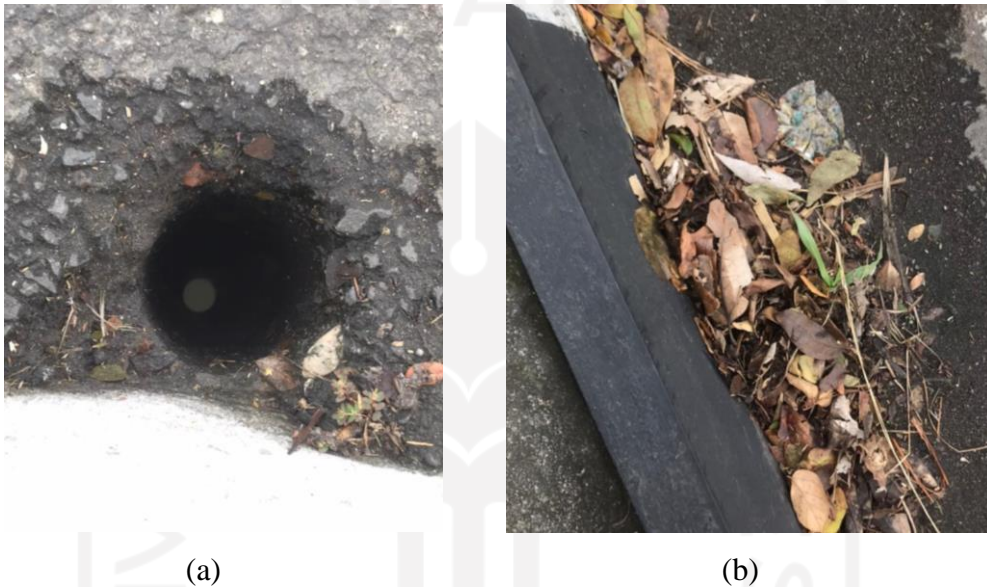
Gambar 5.32 Contoh Pipa Cucuran pada Bentang 2 Jembatan Bogem B
