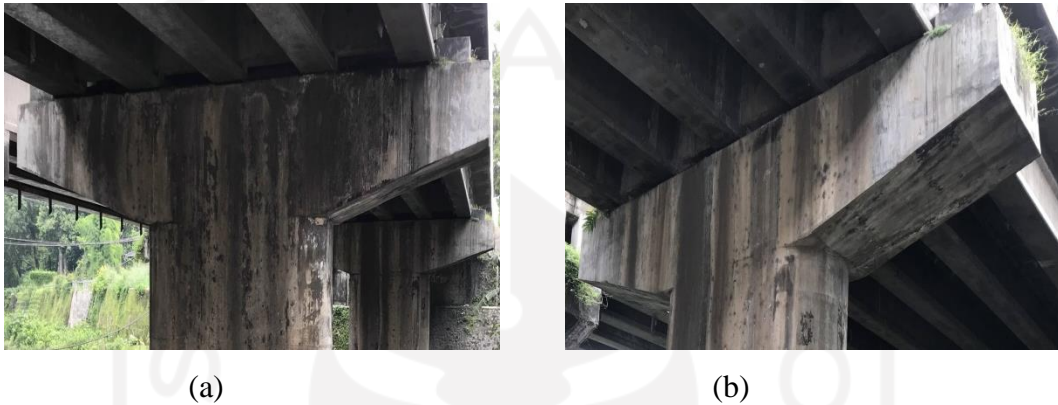
Gambar 5.22 Kepala Tiang (a) Pilar 1 (b) Pilar 2 Jembatan Bogem B
