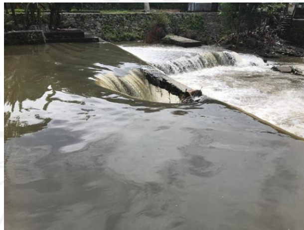
Gambar 5.60 Runtuhnya Groundsill
