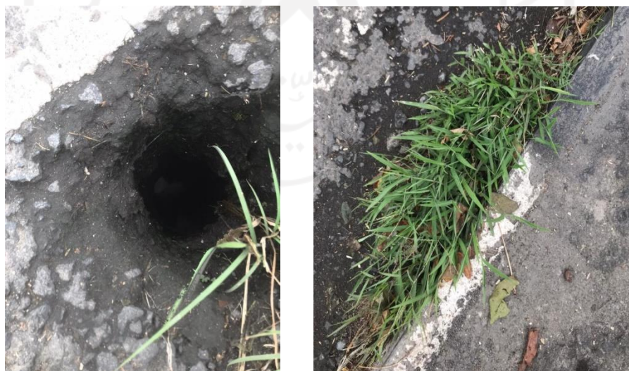
Gambar 5.31 Contoh Pipa Cucuran pada Bentang1 Jembatan Bogem B
