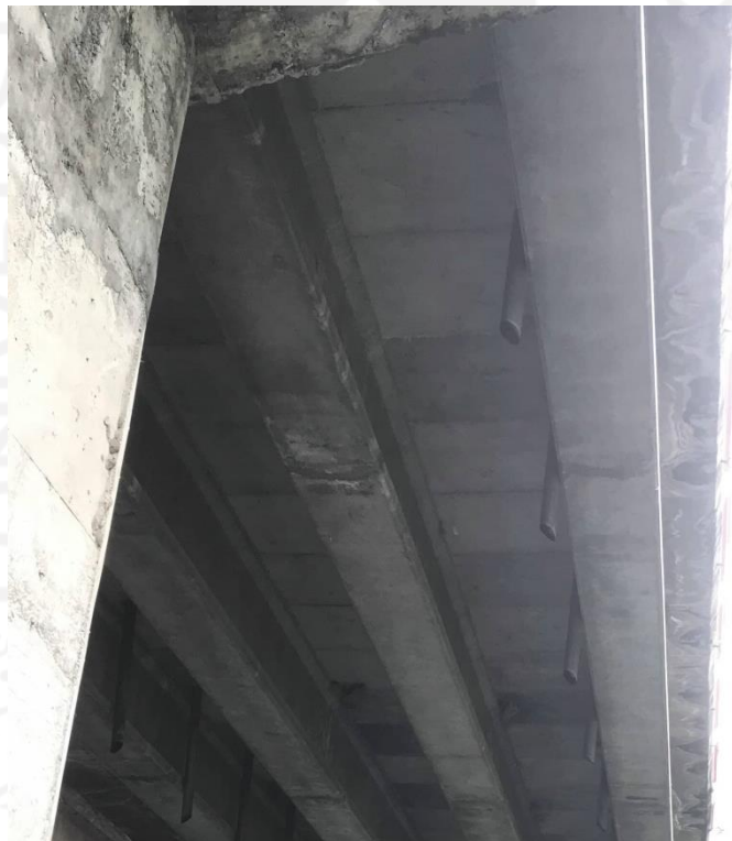
Gambar 5.46 Kondisi Gelagar Bentang Kedua Jembatan Bogem C
