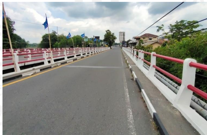
Gambar 5.12 Permukaan Lantai Jembatan Bogem A
