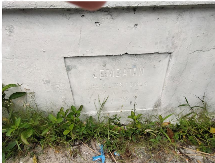
Gambar 5.21 Papan Nama Jembatan Bogem A
