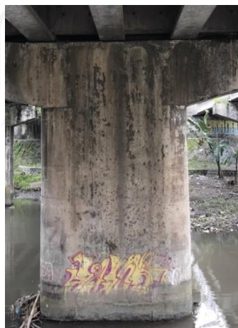
Gambar 5.23 Kondisi Pilar 1 Jembatan Bogem B
