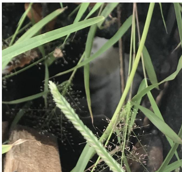
Gambar 5.13 Contoh Pipa Cucuran Tidak Tersumbat Pada Bentang 1 Jembatan Bogem A
