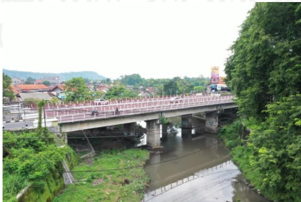
Gambar 5.2 Tampak Samping Jembatan Bogem
