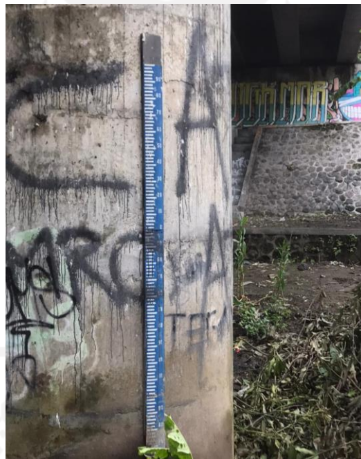
Gambar 5.20 Peilscale Pada Pilar 2 Jembatan Bogem A
