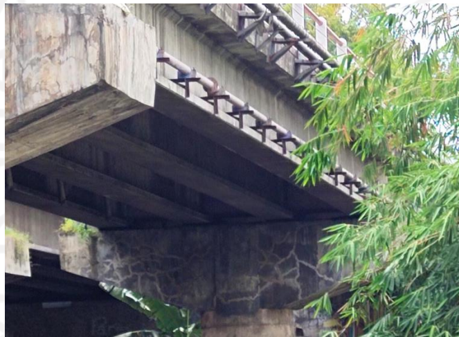
Gambar 5.7 Kondisi Gelagar Bentang Kedua Jembatan Bogem A
