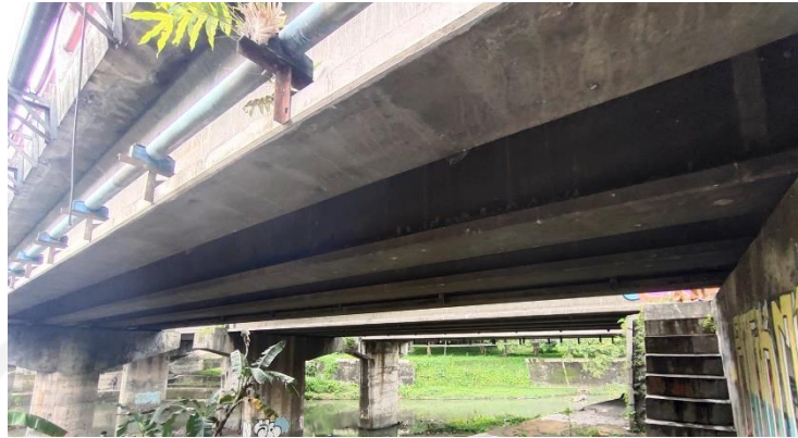
Gambar 5.8 Kondisi Gelagar Bentang Ketiga Jembatan Bogem A
