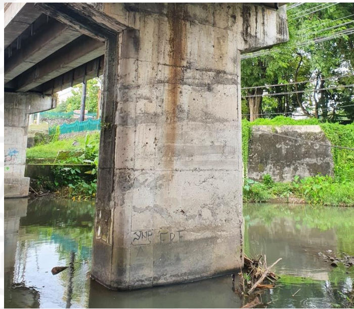
Gambar 5.44 Kondisi Pilar 2 Jembatan Bogem C
