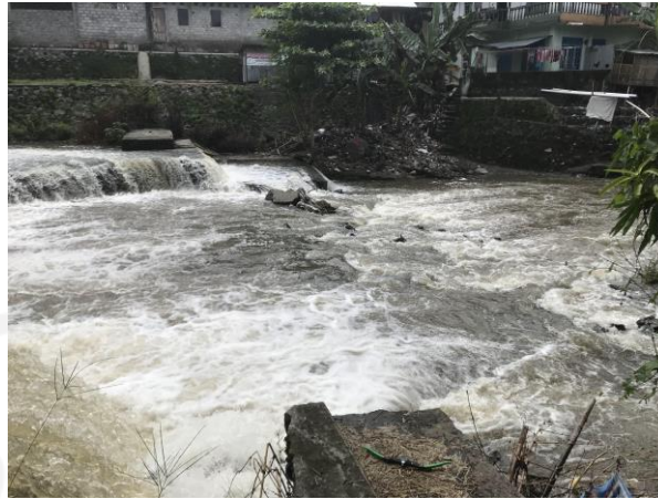
Gambar 5.61 Kerusakan pada Lantai Belakang
