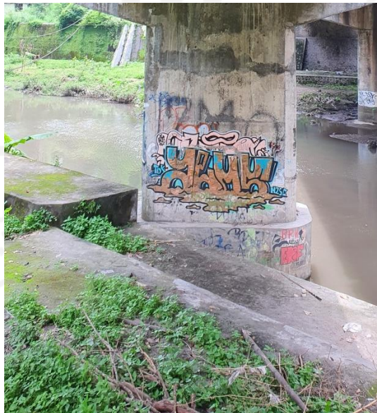
Gambar 5.43 Kondisi Pilar 1 Jembatan Bogem C
