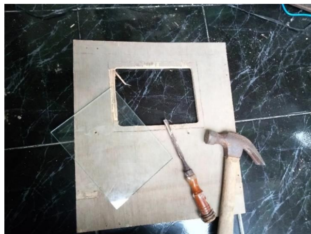
Gambar 3.5 Pembuatan Pintu Inkubator Penetas Telur
