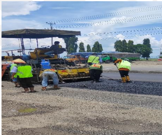
Gambar 3.3 Pengaspalan yang di pimpin pengawas lapangan
