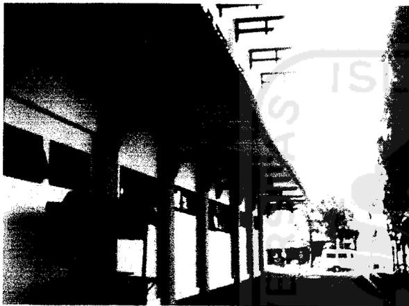
Gambar 11 : Eksterior samping bangunan, plafon disangga balok kantilever
