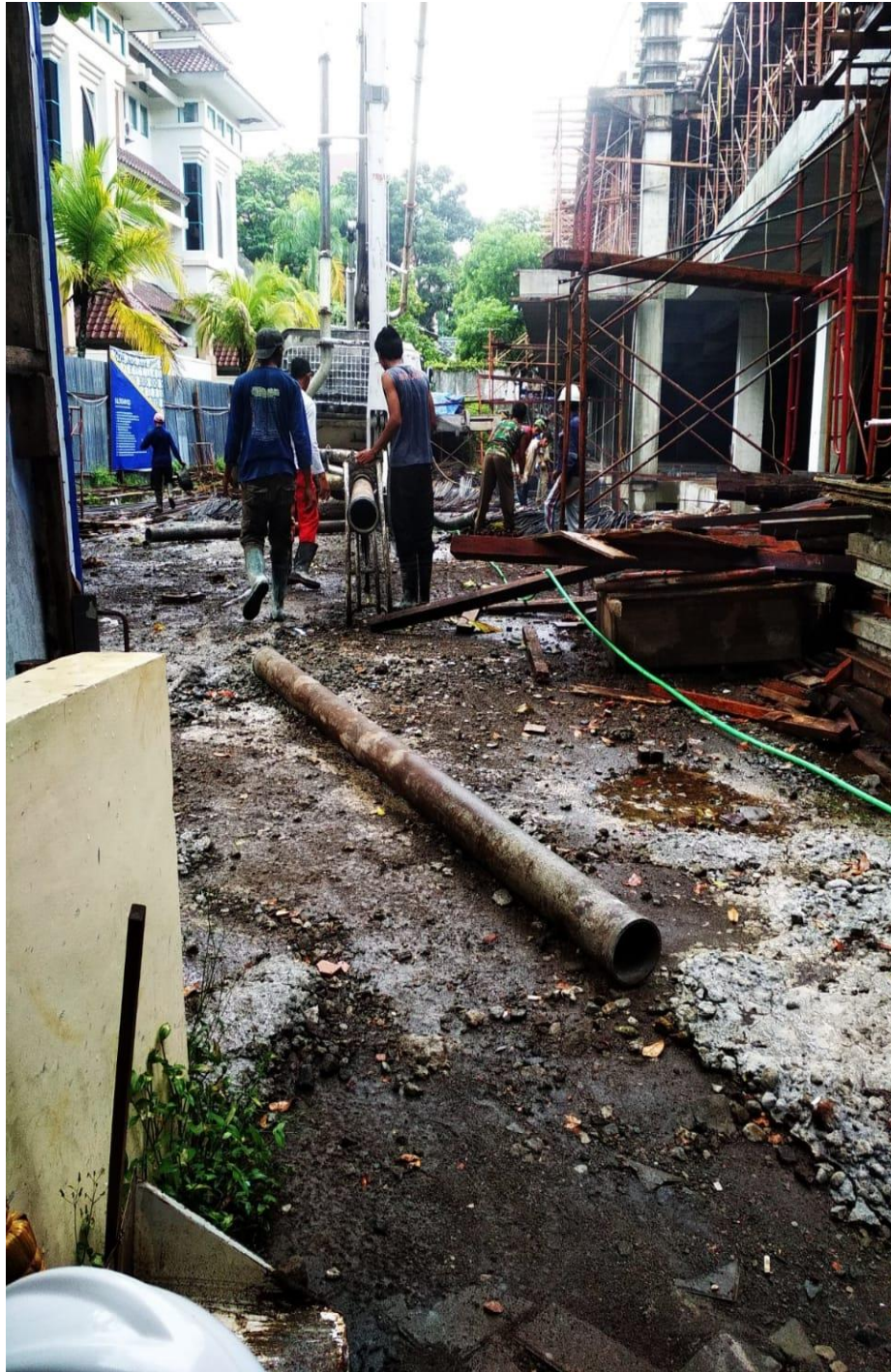
Gambar L.1.4 Persiapan Pengecoran Kolom
