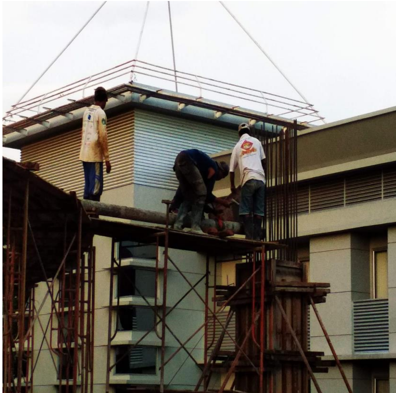
Gambar L.1.2 Pemasangan Tulangan
