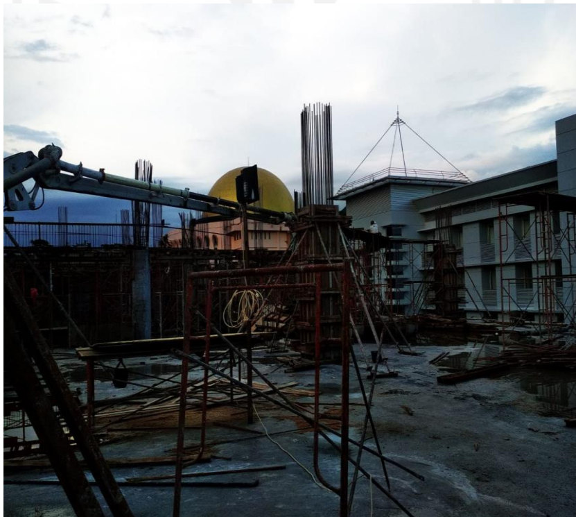
Gambar L.1.3 Pemasangan Bekisting
