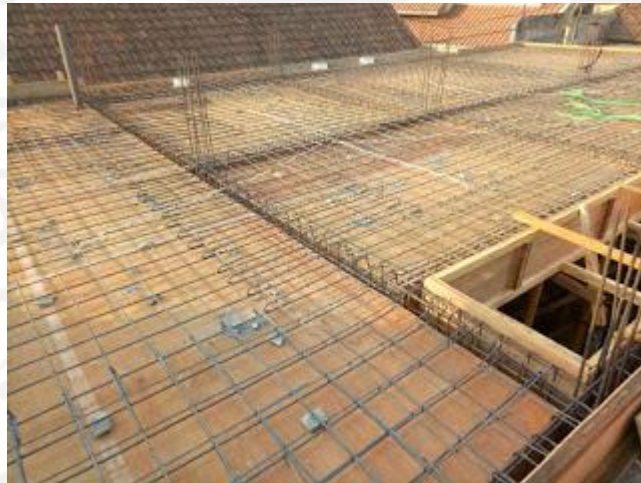
Gambar 3.2 Bekisting Pelat lantai
