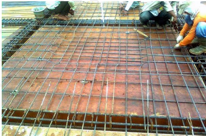
Gambar 3.1 Pembuatan Pelat Lantai
