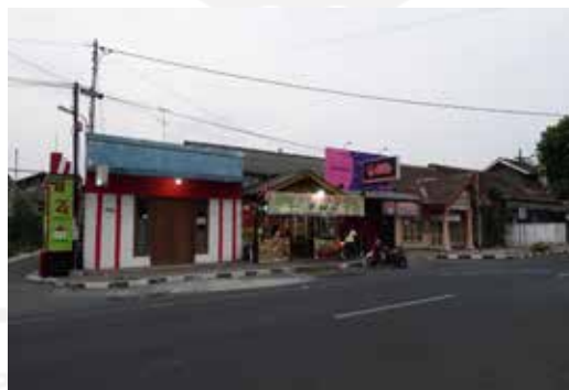
6. Bangunan Perdagangan dan Jasa Sumber: Penulis, 2019
