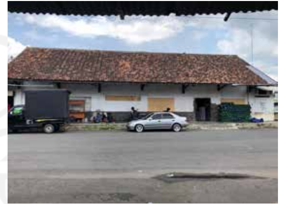
Tampak Samping Bangunan A Sumber: Penulis, 2020
