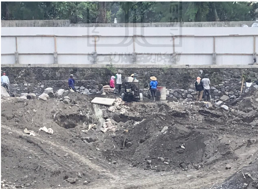
Lampiran 8.2 Gambar pekerjaan pemasangan batu
