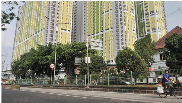
Gambar 1. 29 View bangunan Rusunawa Pasar Rumput
