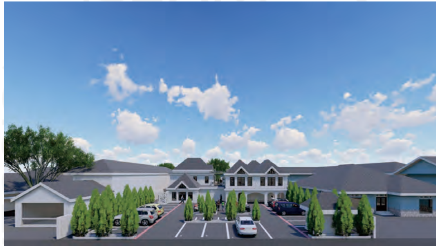
Gambar 6.1 Tampak Depan Bangunan
