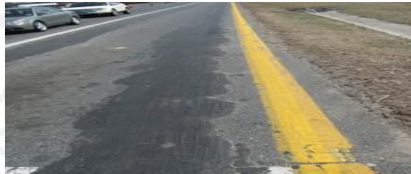
Gambar 3.38 High Severity Level pada Kegemukan ( Bleeding or Flushing )
