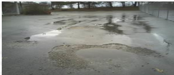
Gambar 3.33 High Severity Level pada Pelepasan Butiran ( Ravelling )
