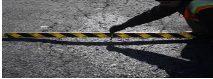
Gambar 3.25 Medium Severity Level pada Amblas ( Depression )
