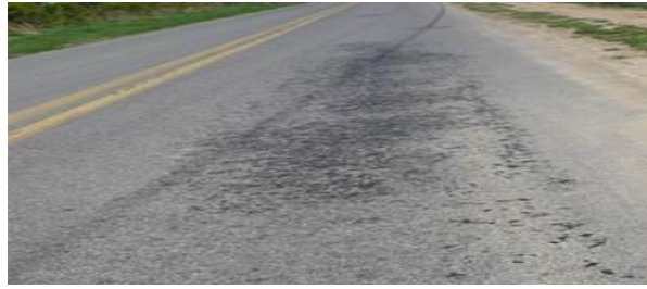
Gambar 3.37 Medium Severity Level pada Kegemukan ( Bleeding or Flushing )
