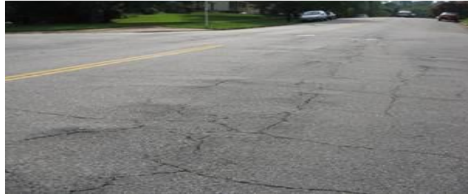
Gambar 3.21 Low Severity Level pada Keriting ( Corrugation )
