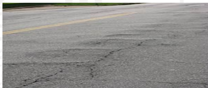
Gambar 3.23 High Severity Level pada Keriting ( Corrugation )
