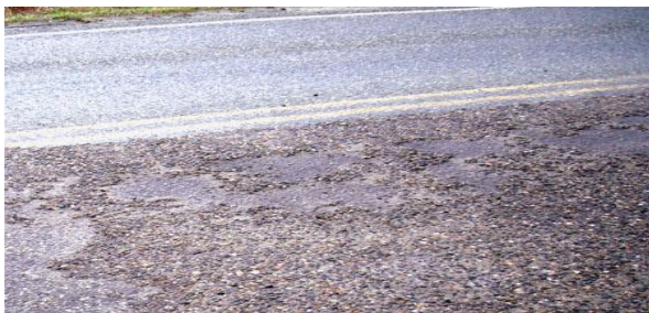
Gambar 3.34 Pengelupasan Lapisan Permukaan
