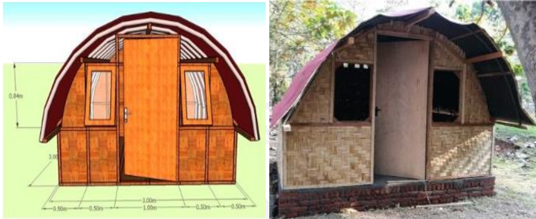
Gambar 2.1 Sketsa dan Prototipe Hunian Sementara Lumbung bambu
