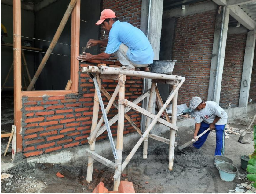
Lampiran 5 Pemasangan Bata Merah
