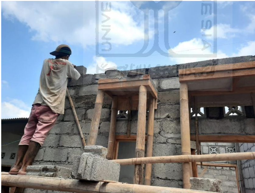
Lampiran 6 Pemasangan Batako
