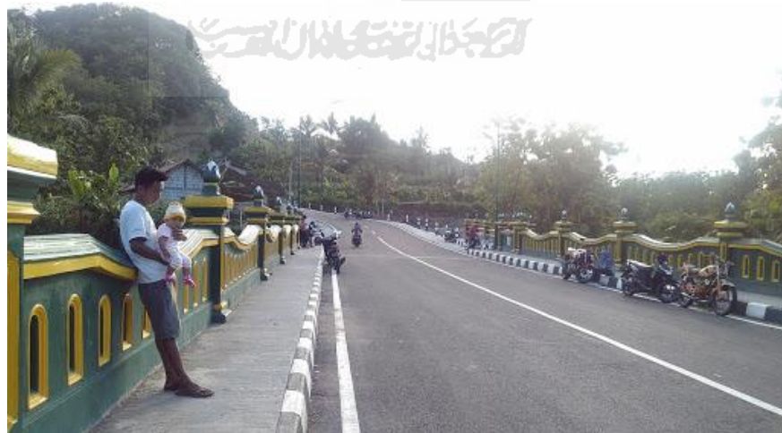
Gambar 4.2 Jembatan Lemah Abang (Sumber: Google)
