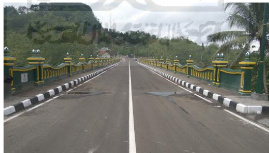
Gambar 1.1 Jembatan Lemah Abang (Sumber : Google)
