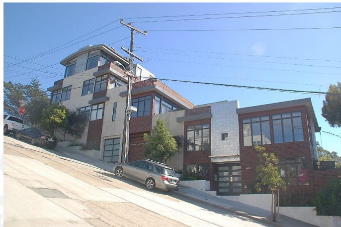
Gambar 3.16 Kondisi Tanah Miring Pada Bangunan
