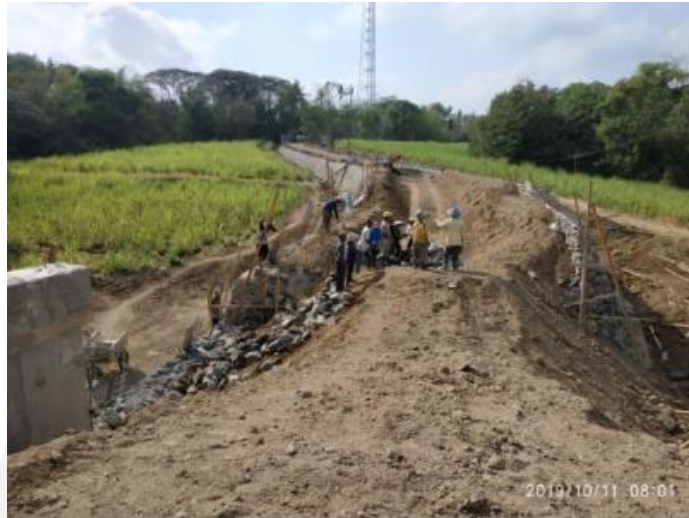
Gambar 5.16 Tenaga Kerja Saat Memindahkan Material
