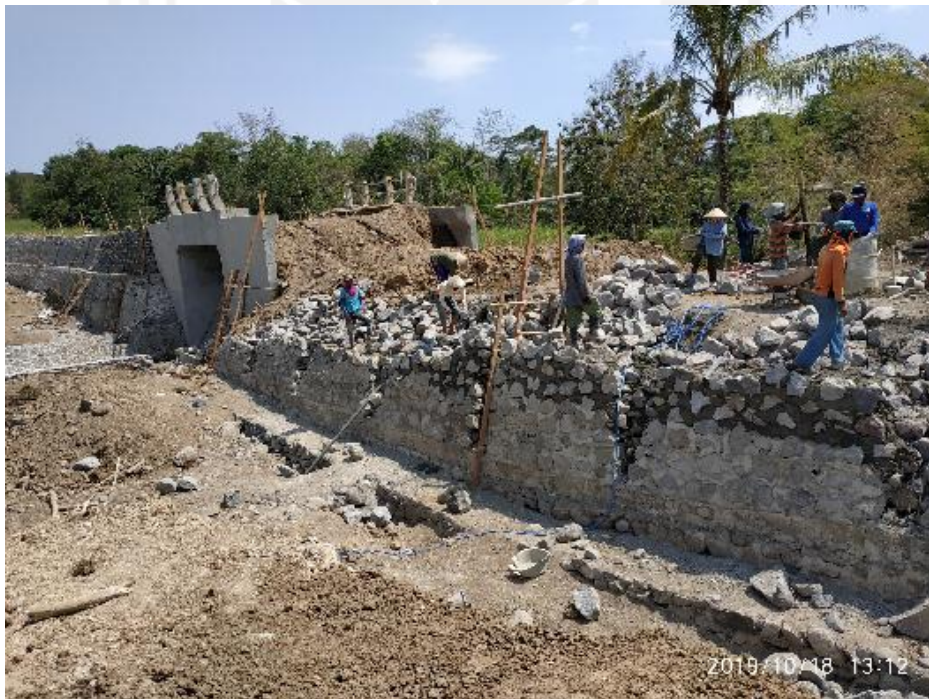
Gambar L-2.3 Gambar Tenaga Kerja Pasangan Batu
