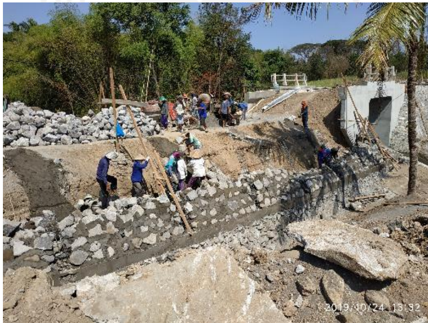
Gambar L-2.2 Gambar Tenaga Kerja Pasangan Batu
