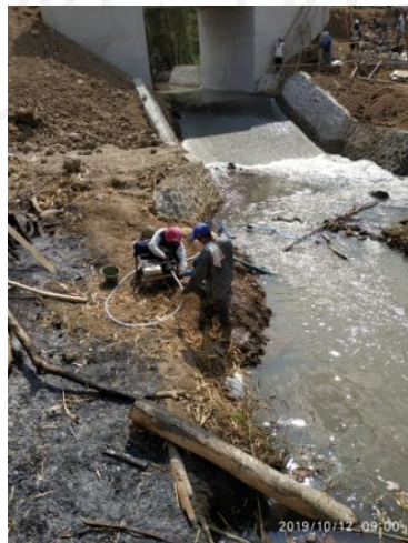
Gambar 5.17 Tenaga Kerja Saat Memperbaiki Pompa Air
