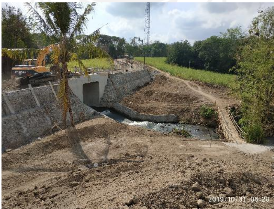
Gambar L-2.6 Gambar Pasangan Batu Yang Sudah Jadi
