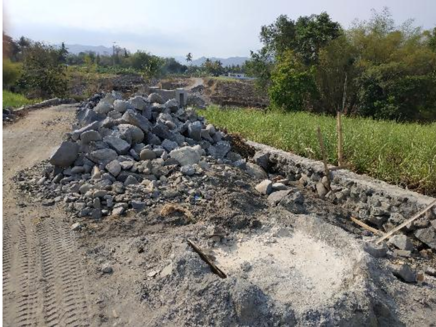
Gambar L-2.1 Gambar Material Pasangan Batu
