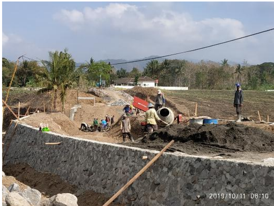
Gambar L-2.5 Gambar Tenaga Kerja Pasangan Batu
